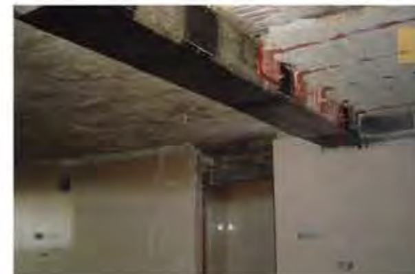
مقاوم سازی تیر بتنی با استفاده از الیاف CFRP
