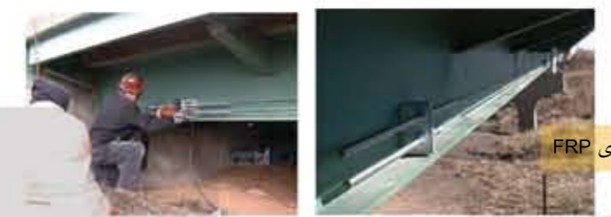
مقاوم سازی پایه پل با استفاده از نوارهای FRP
