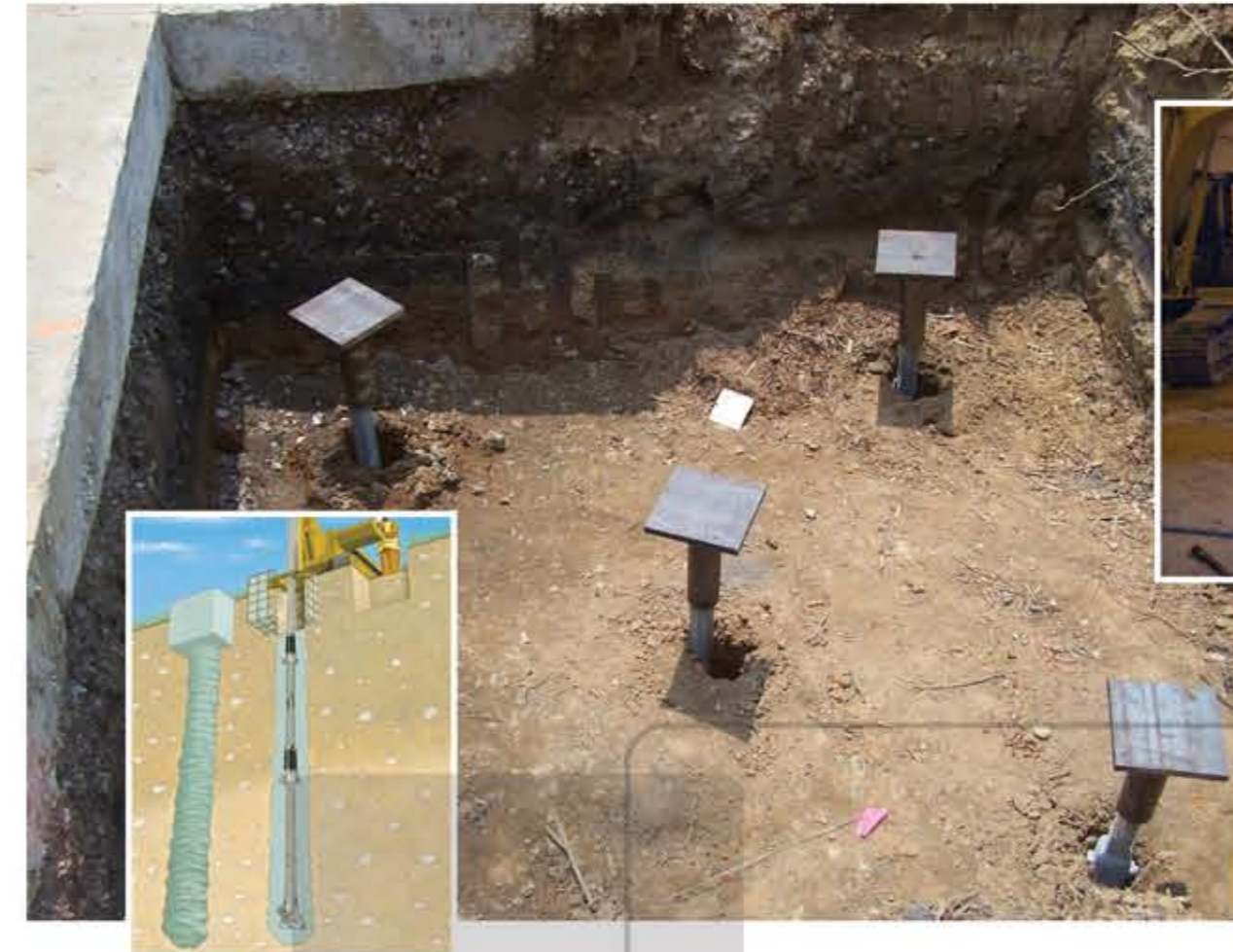
تثبيت و مقاوم سازی خاک توسط ریزشمع Micropile
