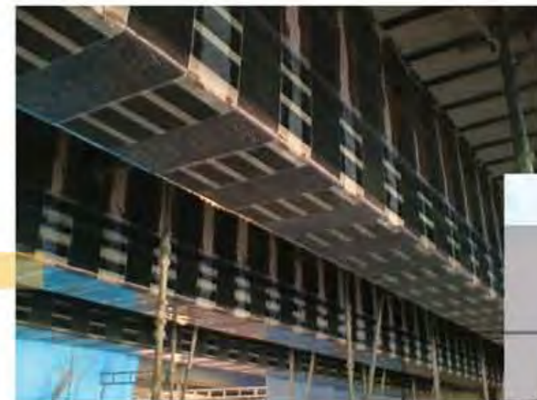
مقاوم سازی پل بتنی با استفاده از الیاف CFRP
