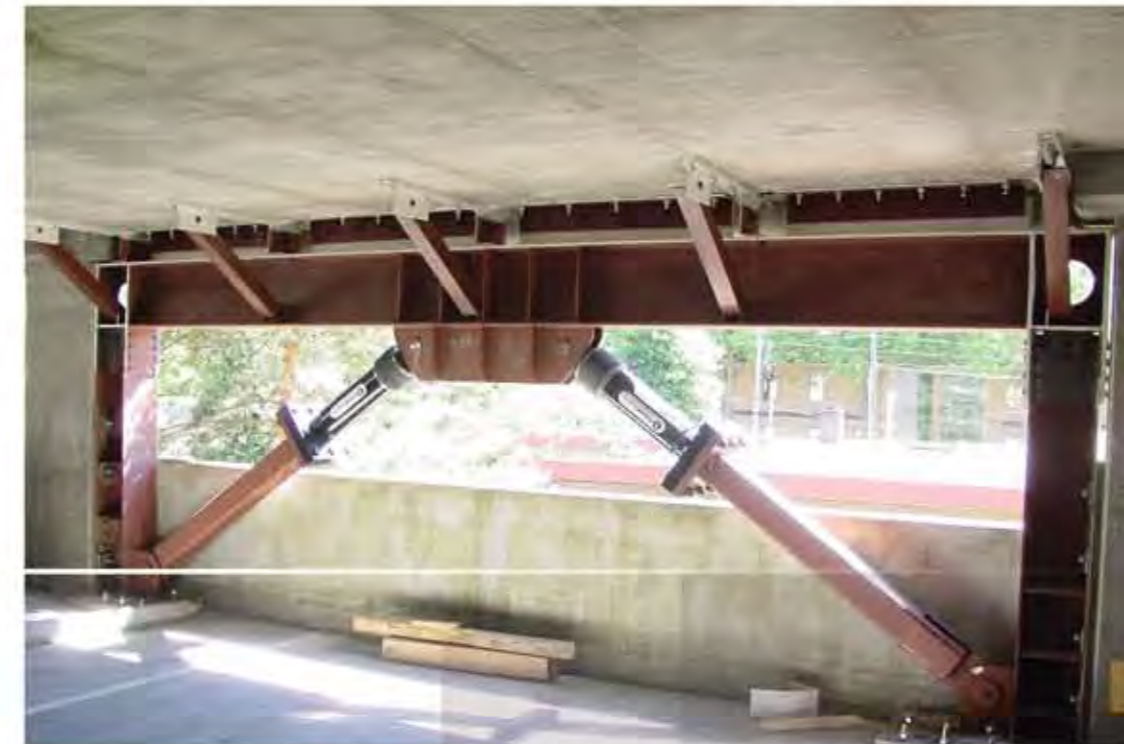
میراگر ویسکوز مایع
