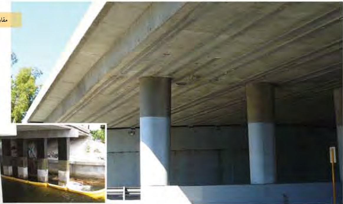
مقاوم سازی عرشه پل با استفاده از میراگر و جداگرهای لرزه ای (Damper)
