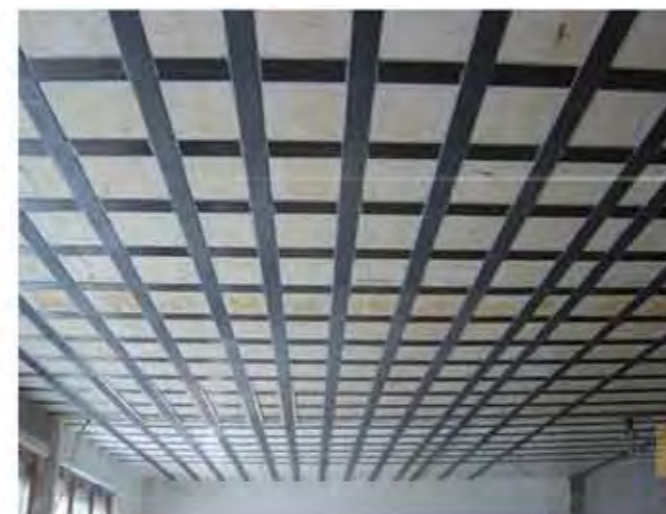
مقاوم سازی دال بتنی با مصالح CFRP
