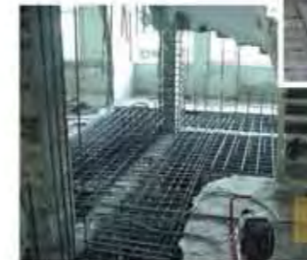
تقویت فونداسیون و افزودن دیوار برشی
