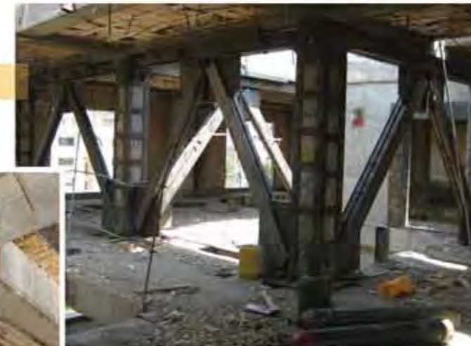
افزایش مقاومت خمشی، برشی و فشاری ستون با استفاده از ژاکت فلزی و استفاده از مهاربند فولادی
