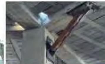
اتصال دستک فولادی در قاب خمشی بتنی
