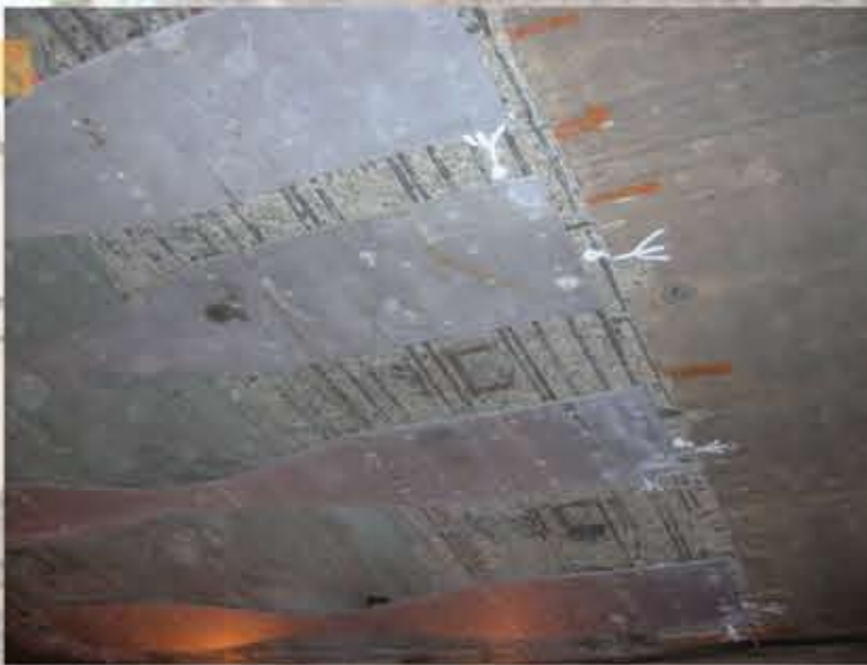
مقاوم سازی سقف تونل با ورق های فولادی
