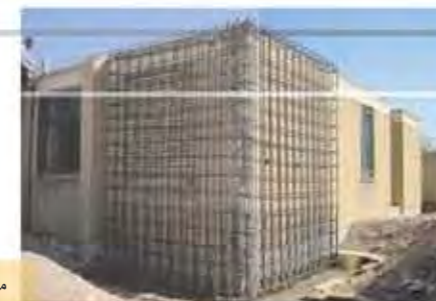
مقاوم سازی به وسیله تسلیح دیوار و شاتکریت بتنی
